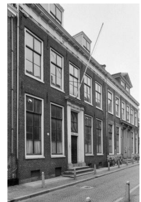
Boothstraat 17 (collectie Rijksdienst voor het Cultureel Erfgoed)
