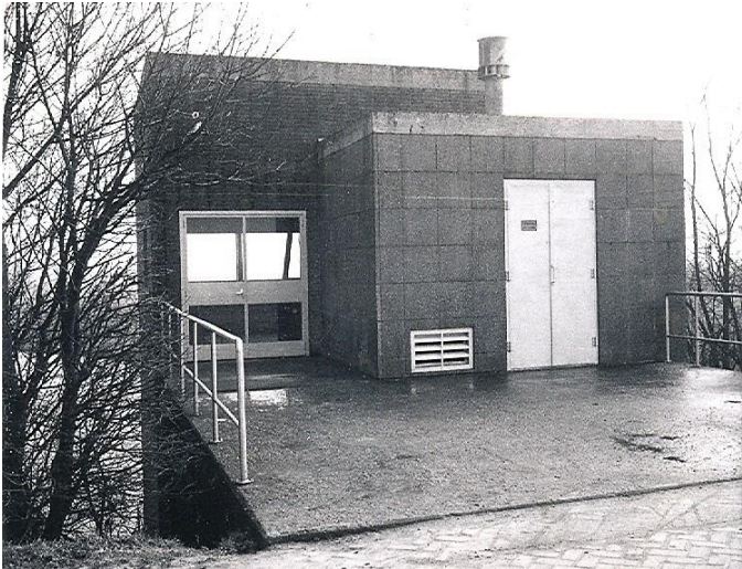
Gemaal Ploegmakers toegang
